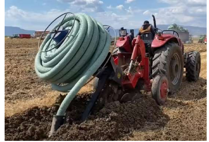
Tarla drenaj boruları çekilerek tuzluluğun önlenmesi
