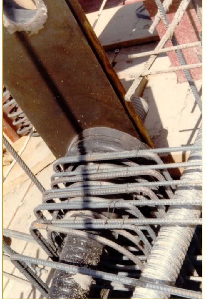
Şekil III.1.8. Art çekme kablosu çıkış detayı
