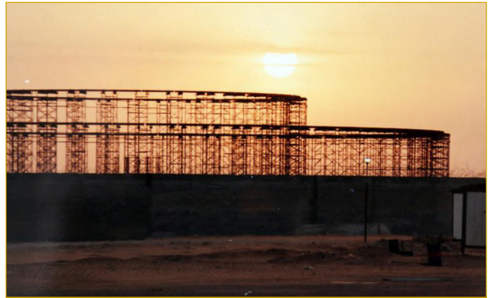
Şekil III.1.21. Küresel kubbe için geçici iskele
