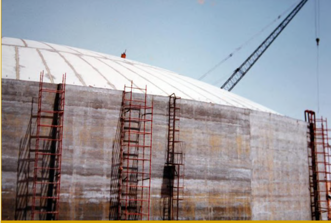
Şekil III.1.23. Kubbe bağlantılarının tamamlanması
