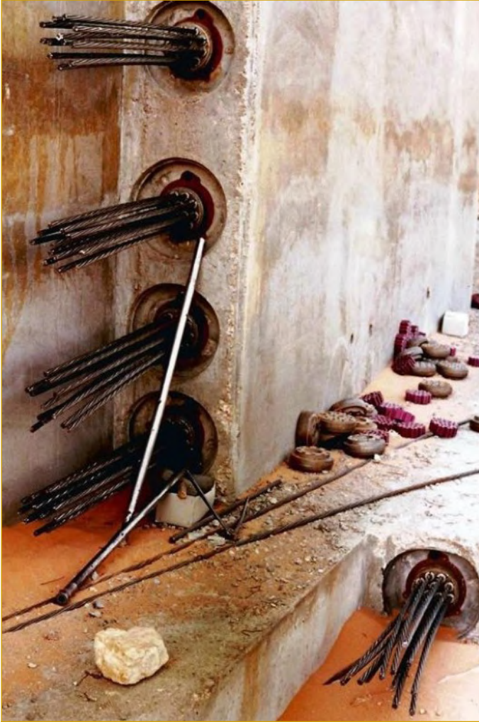
Şekil III.1.18. Duvar yatay art çekme kabloları
