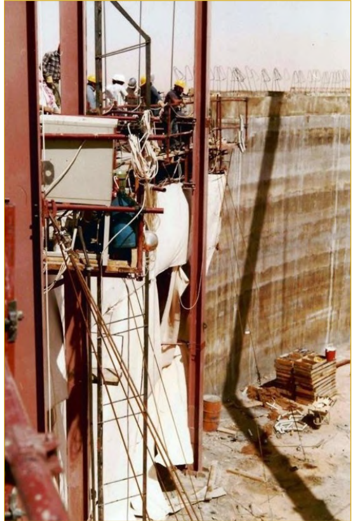
Şekil III.1.13. Duvar üst çember kirişi hazırlığı
