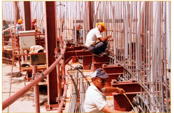
Şekil III.1.9. Duvar donatıları
