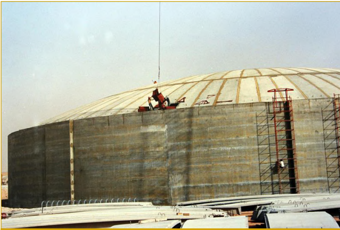
Şekil III.1.24. Kubbe geçici iskeletonin sökülmesi
