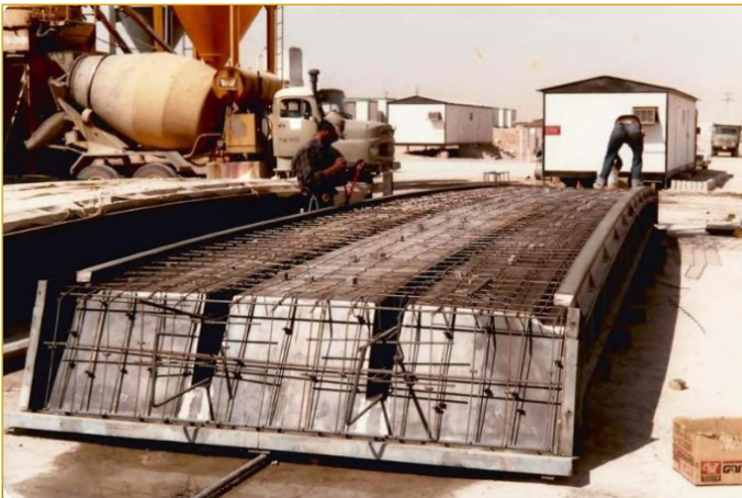
Şekil III.1.19. Küresel kubbe ön üretimli eleman kalıbı Tip1
