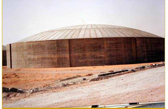
Şekil III.1.26. Betonarme inşaatı tamamlanmış depolar
