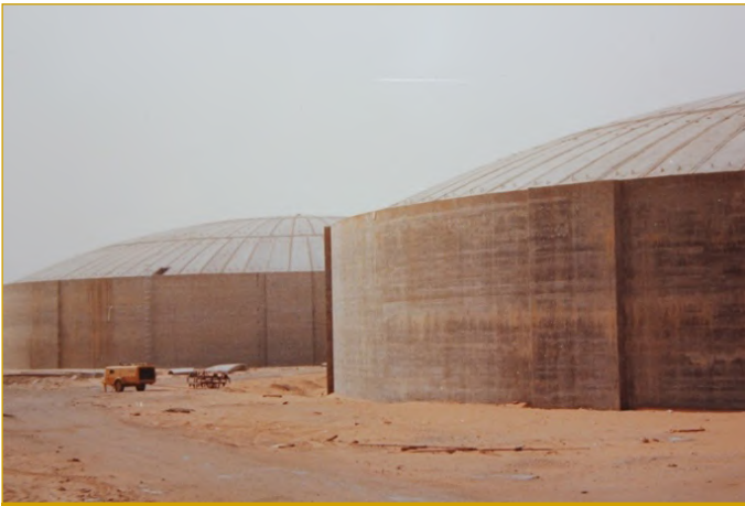
Şekil III.1.25. Betonarme inşaatı tamamlanmış depolar
