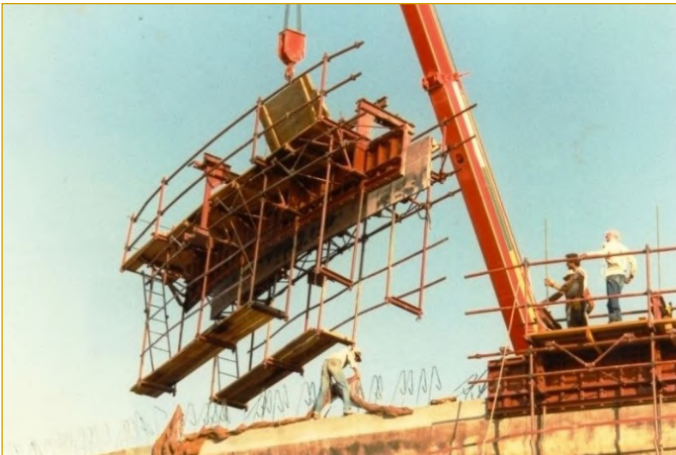
Şekil III.1.16. Kayar kalıp sökülmesi
