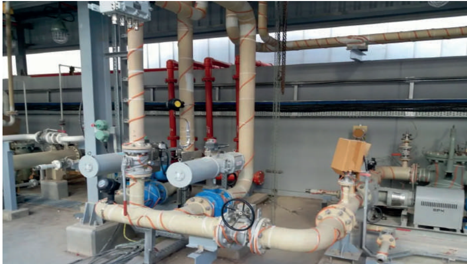
Şekil 220 Elektrikli Isıl İzleme Sistemi Uygulama Örneği
