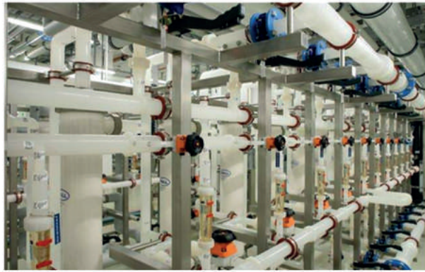
Şekil 12 Demineralize Su Kullanım Tesisi Görünüşü
