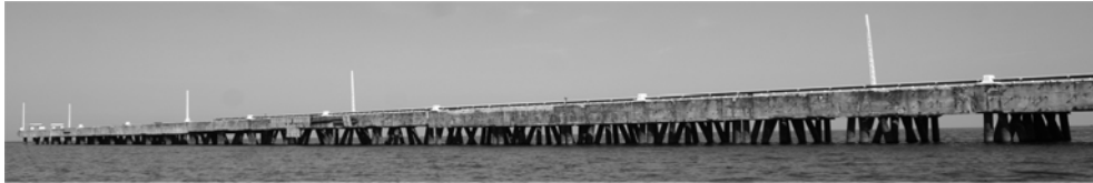
Şekil 15 Beton İskele Görüntüleri.
